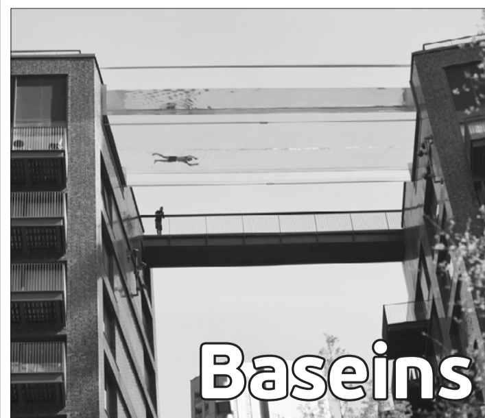
Londonā uzbūvēts pasaulē pirmais gaisa peldbaseins. Caurspīdīgā konstrukcija 35 metru augstumā savieno divas daudzdzīvokļu ēkas.
